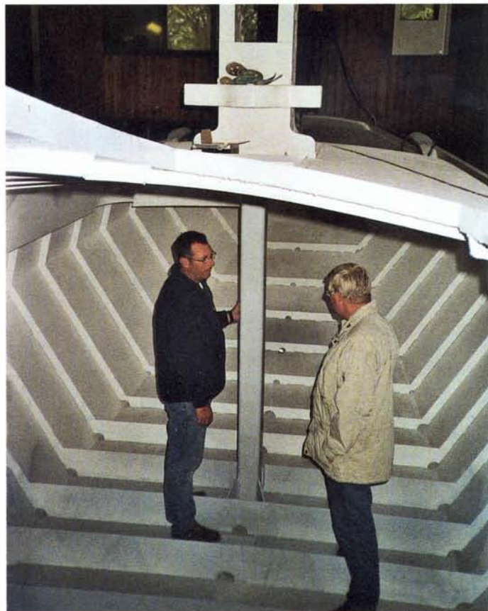
Bouwe en Luuk in de 'bui' van de nieuwe 11,5 m.
