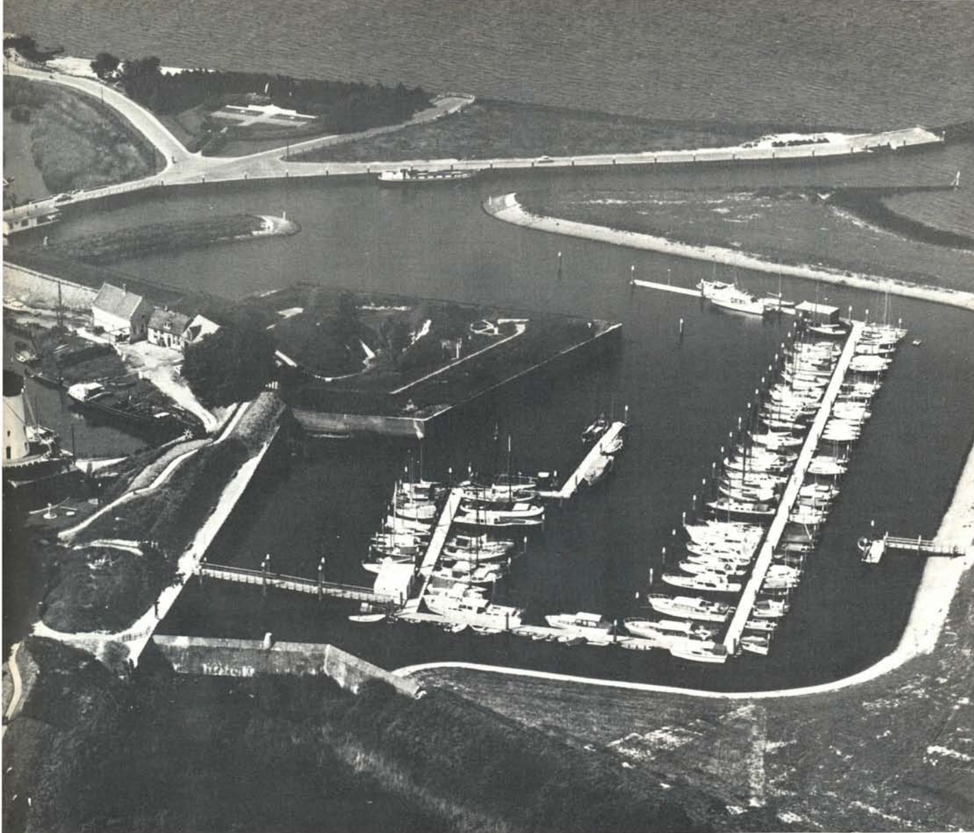
Foto boven: De nieuwe jachthaven vanuit de lucht gezien. Alle plaatsen zijn reeds bezet en voor liefhebbers voor een ligplaats is een wachtlijst aangelegd. (Foto: Panavue)
