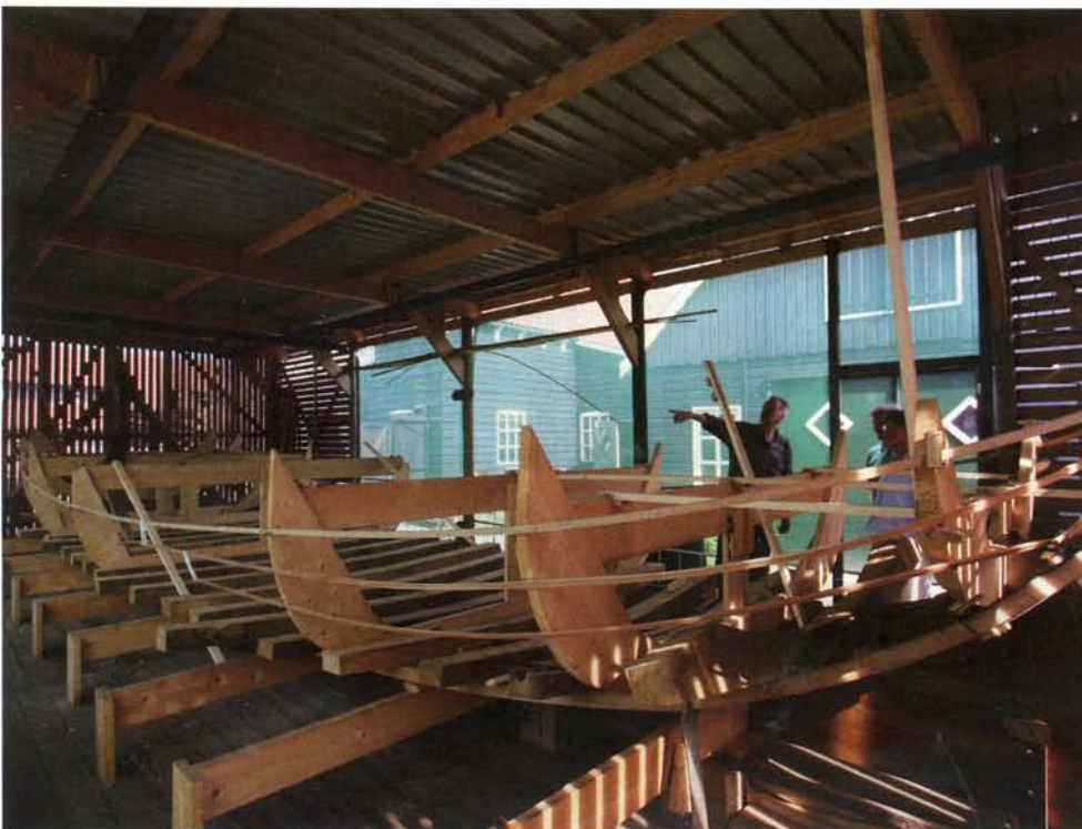
Aan het houten skûtsje Aebelina wordt weer gewerkt. De komende maanden komen de huidgangen op hun plaats.
