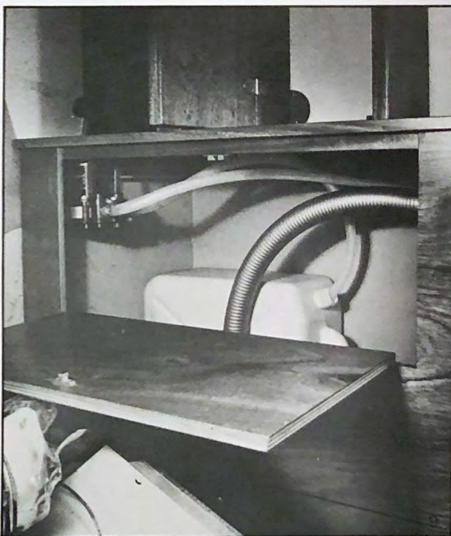
Foto 9 Gootsteenkastje in een 8 meter Grundel. Linksonder in het kastje is een voetpomp ingebouwd. De dikke slang is voor de afvoer.
