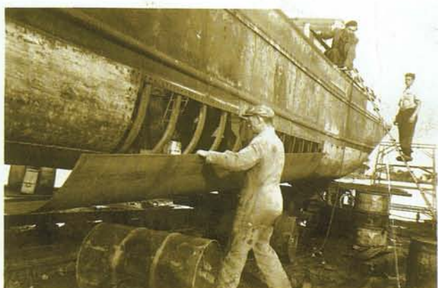
Onder: Een nieuwe kimgang wordt gepast op de werf in Ter Aar.
