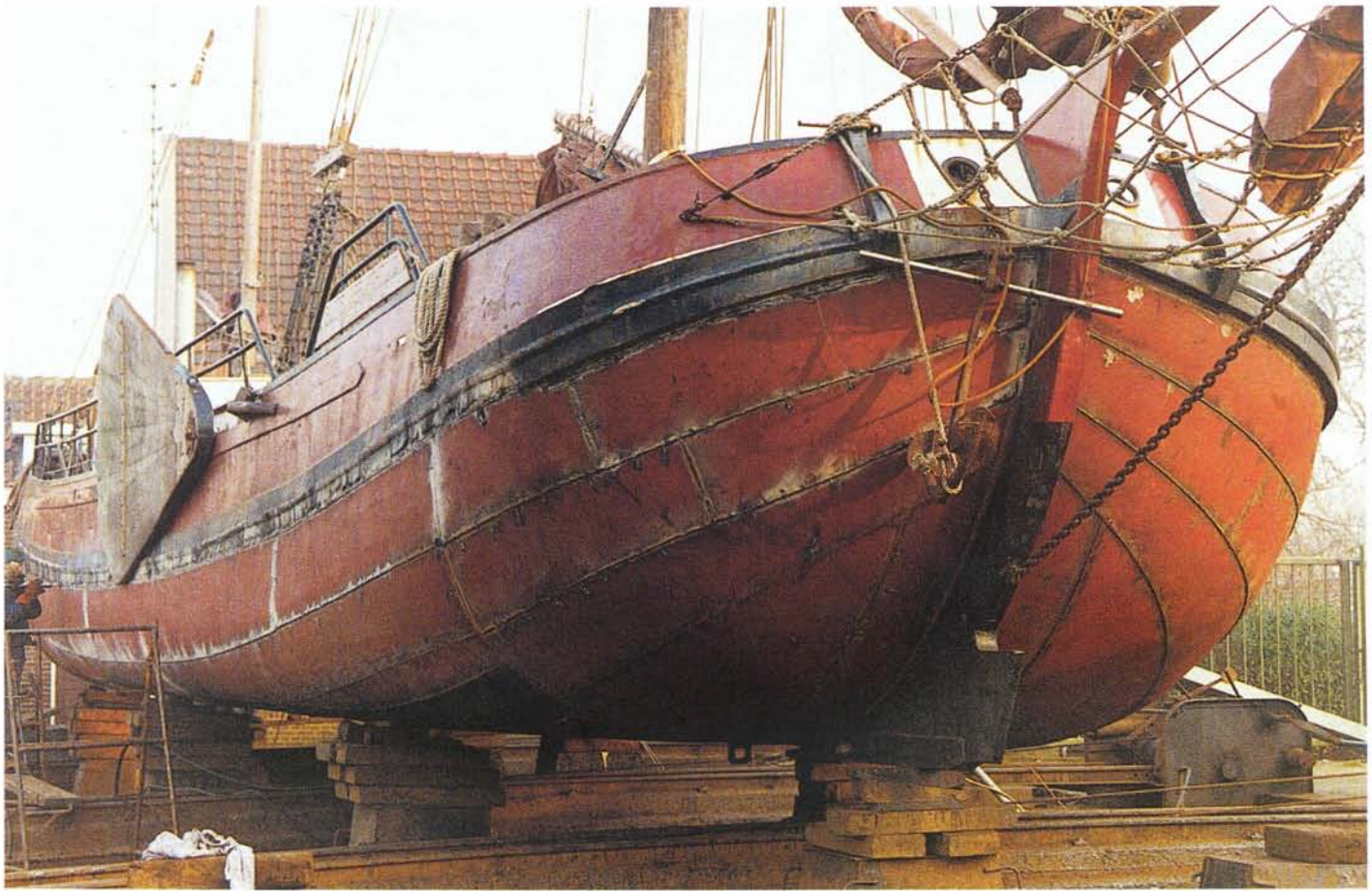
Deze tjalk moest boven en onder water worden gedubbeld. Een fraai stukje vakwerk.
