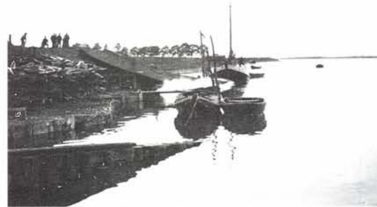
Tewaterlating van de NZ 1 in 1932. Het schip werd binnendijks gebouwd en moest dus over de dijk getrokken worden.
