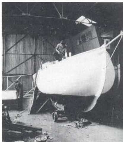
In de jaren zestig werden op de werf waar vroeger Roosjen en Strikwerda zaten, onder leiding van Anton van der Werff, nog drie stalen jollen gebouwd. (Foto Anton van der Werff).
