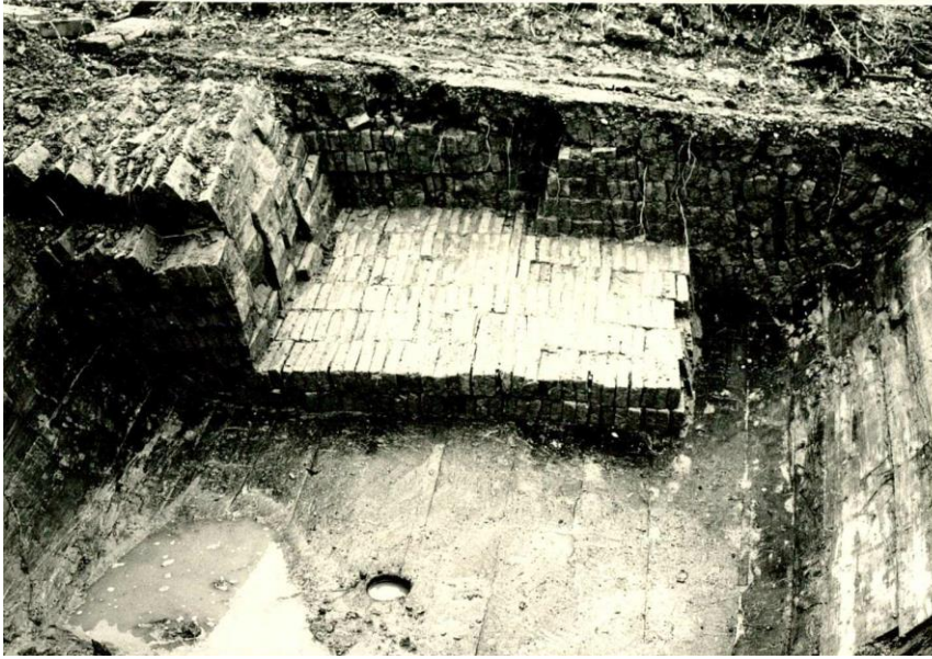
Afb. 15 Een deel van de lading gele bakstenen van het wrak op kavel OU 105 26
