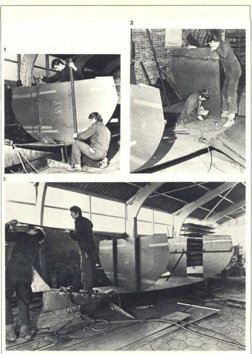
Al vroeg in de morgen is de "kiel gelegd". Een zware I-balk dient als helling; daarop is de scheg met de zware vlakplaat gesteld. Het zware vlak met scheg is niet alleen de ruggegraat van het jacht, maar vormt tevens de zeer laag geplaatste ballast.
