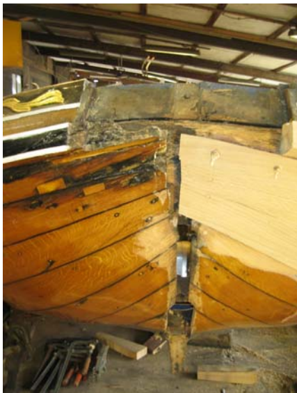
Foto van der Werf. Restauratie in 2005 van het voorschip door Van der Meulen. Van hetgeen hier gedaan wordt is nog niet opgenomen in het schema van 1995. Zo snel kan het gaan.
