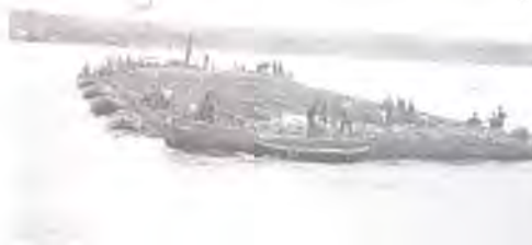
Een zinkstuk wordt beladen. (coll. Baggermuseum)
