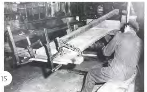
Werfbaas Nieuwendorp aan het branden. Door tijdens het branden het dwarsplankje achterop het vlak, onder de hefboom, naar de ketting toe te schuiven wordt de benodigde kracht gedoseerd om een steeds sterkere kromming te verkrijgen. (foto coll. Gerrit van Driel) Elders werd hiervoor ook wel een dommekracht onder de hefboom gezet.
