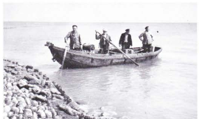
Gemotoriseerde peilboot, Walcheren Zuid. Zie motorkast en stuurwiel aan de zijkant. De stut is hier nog niet opgezet (zie volgende foto). Beeldbank Ritthem.
