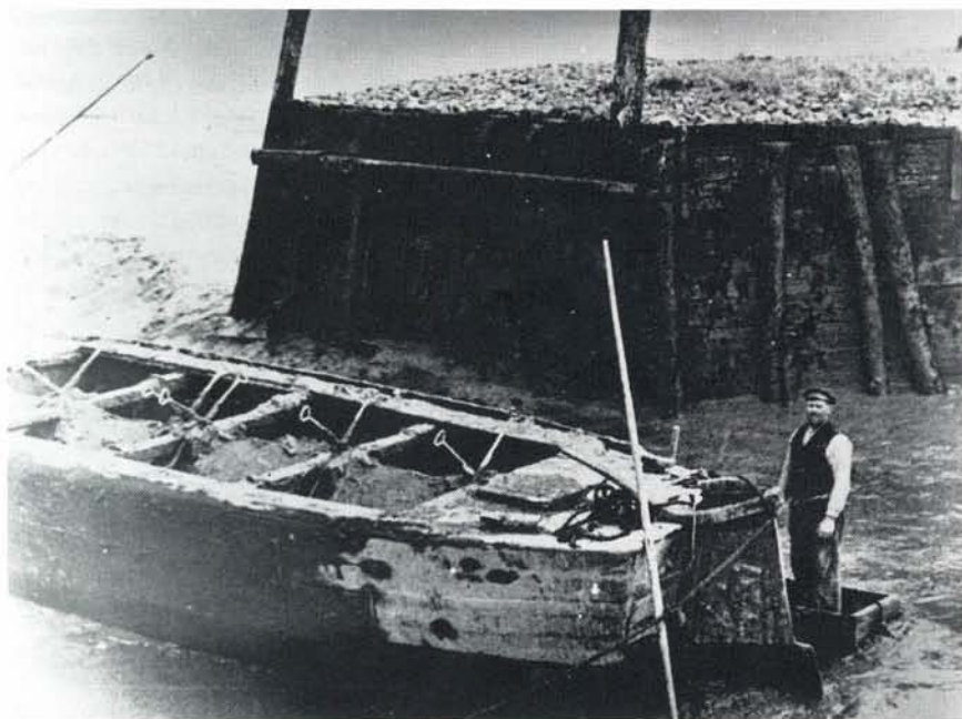
Frans de Rooij in zijn modderbak (1930). Staande in een klein bakje werd de grote bak met modder volgeschept. Met opkomend water werd de vracht naar „buiten” geboemd en aldaar gelost. In de zomer werden soms elf vrachten per week naar buiten gebracht, voor de prijs van 30 cent per kubieke meter. De inhoud van de bak was 8 m 3 .
