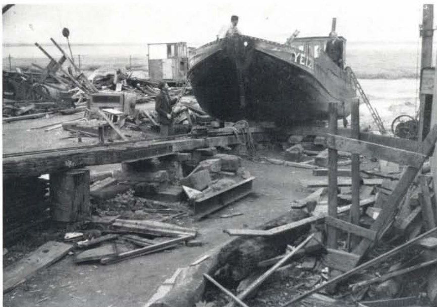
De Ye. 126 op de helling bij Petrus Verras (1954). De schepen werden toen nog omhoog getrokken over een uitgeholde balk. Het schip zat op een zogenaamde „tong” of slede, die voor het hellingen overvloedig met vet werd ingesmeerd.
