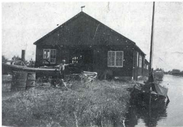
De oorspronkelijke bouwloods in Aalsmeer. Boven. Haaks op de oude loods is een nieuwe loods gebouwd. Rechts onder. Alle materialen en personen moesten altijd worden overgeroeid.
