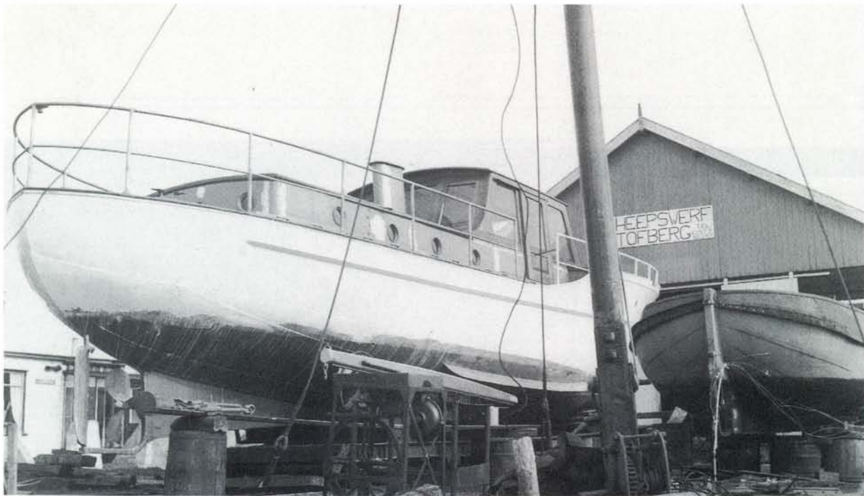
Reparatieklus en verbouwing aan spitsgatmotor-kruiser.
