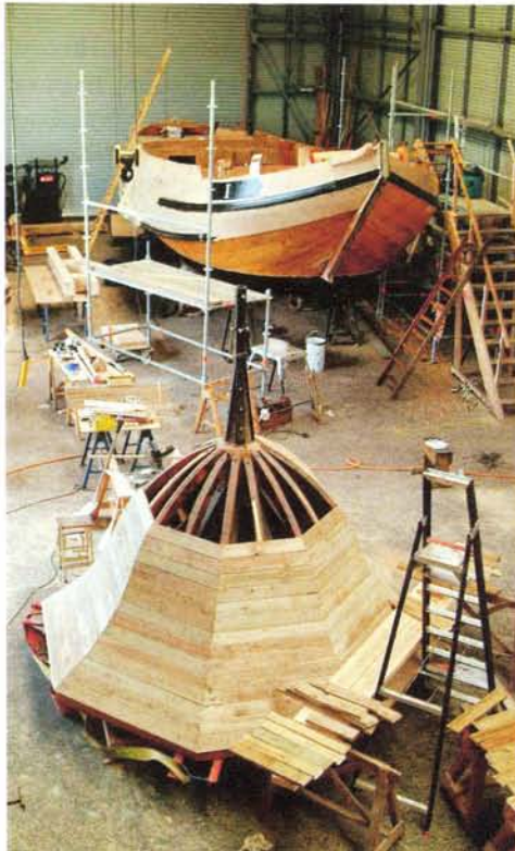
De kap van de lantaarn, met daarnaast de stijlen waarop die later moet worden geplaatst.
