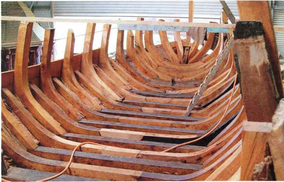
Nagenoeg het hele spantenwerk van D'n Bruinen werd hernieuwd.
