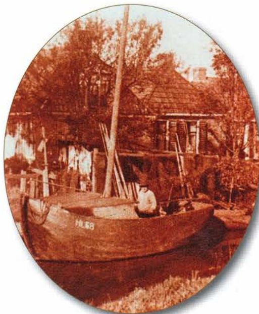
Molkwerum, 1932. Een Wildschutjoll met een opklapbaar voordek, de 'blaasbalg', van Klaas Jelles Zeldenrust. Een joll met scherpe waterlijnen, zonder slemphouten tegen de voorsteven. Wel met een 'snoes' voor de ankerlijn. (Foto: Fen Fryske Groun, uit: archief Jan Visser, Stavoren)
