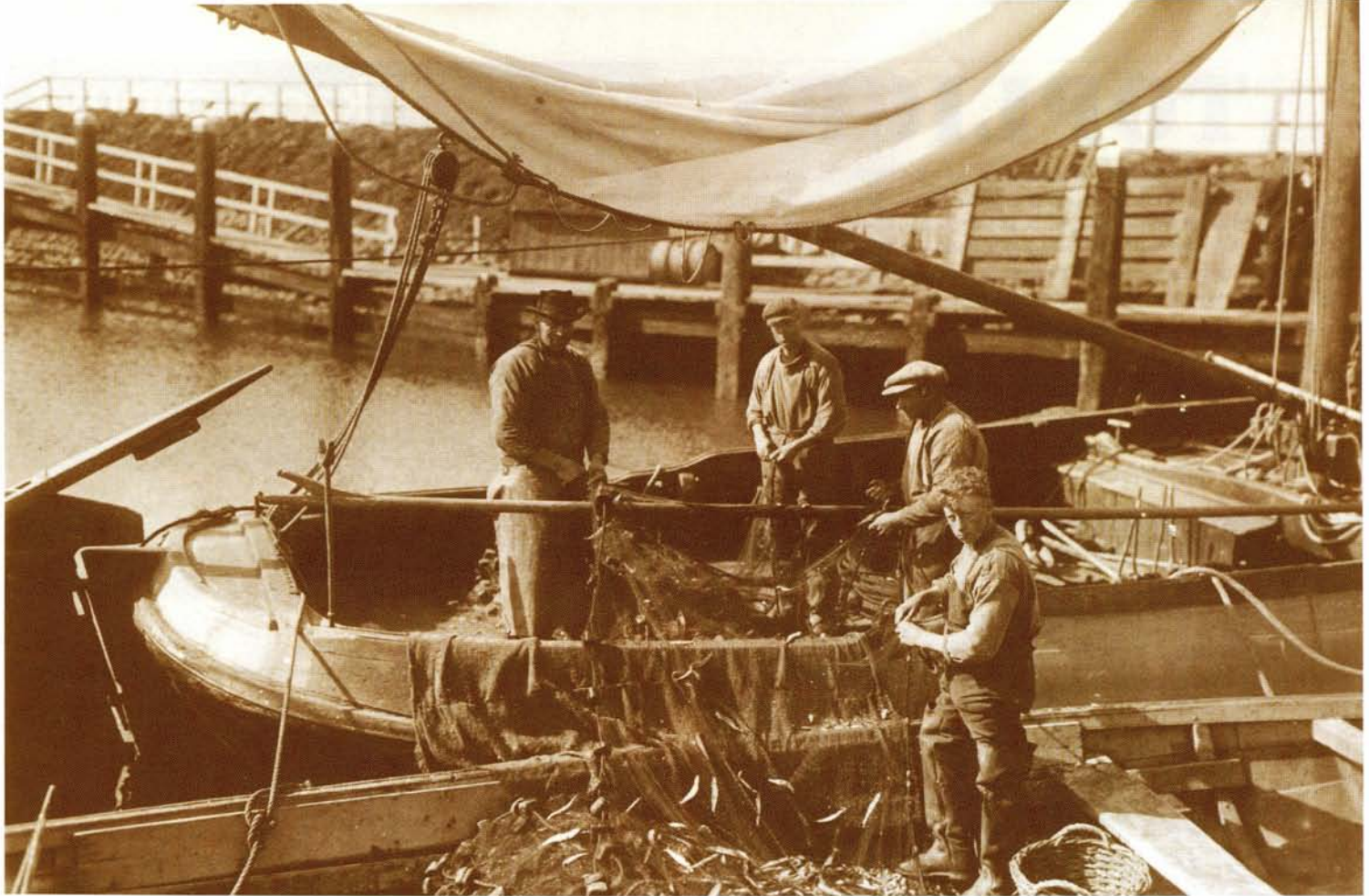
Haven De Haukes, 5 mei 1926. Dit is de WR 168, een aak die gebouwd is door Kees Nijdam te Van Ewijcksluis. Aan boord staan schipper Jan Metselaar, met zoons Jan en Cor, en Pauw Kroon (met pet). Het net wordt uit de vlet over de stok getrokken, om de ansjovis eruit te halen. Tussen vlet en aak is een kleedje gehangen, zodat er geen vis in de haven valt.
