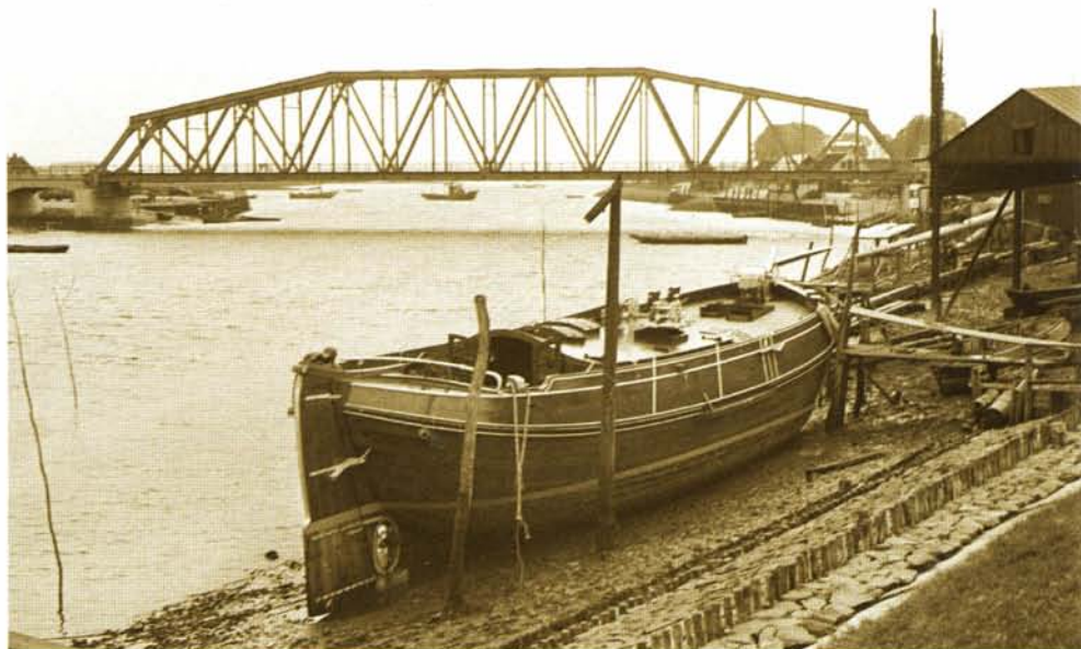
Loopplankje naar de wal en je bent klaar om er aan te werken. Op de achtergrond de brug over de Eendracht die de werf naar het zuiden afsloot voor schepen met een vaste mast. 3-10-1934
