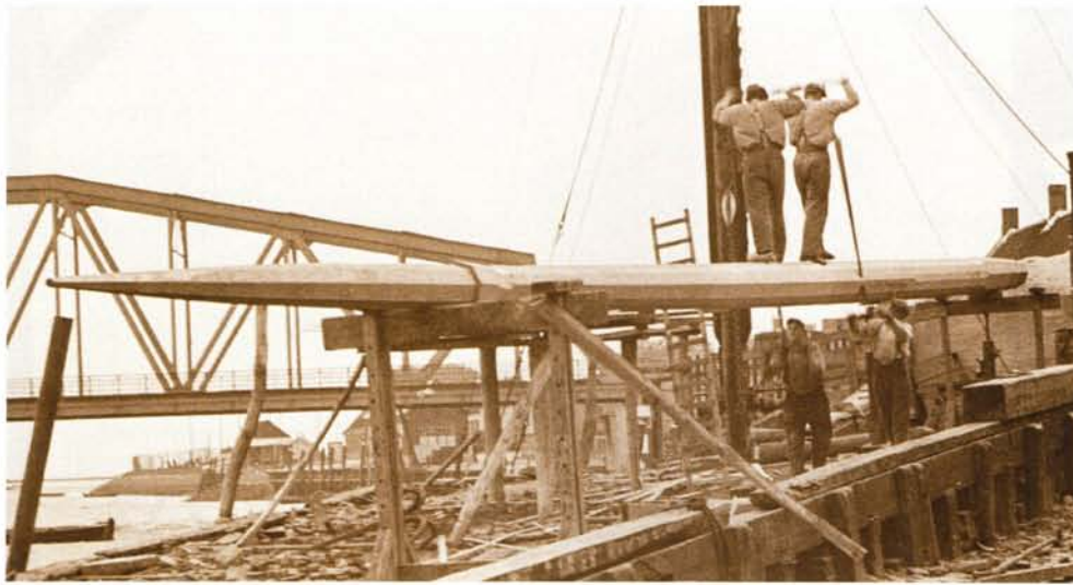
De werf met de mast in bewerking. 3-10-1934
