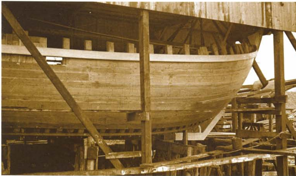
De berghouten worden geschaafd. Let op de krullen. De balken nemen nogal wat plaats in op de werf. 24-11-1933. Onder: De berghouten zijn gemonteerd en de huid is bijna dicht. 30-12-1933.
