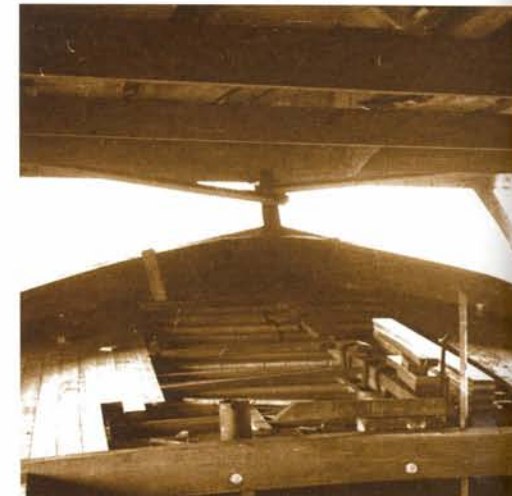
Het voordek in aanbouw 13-4-1934.
