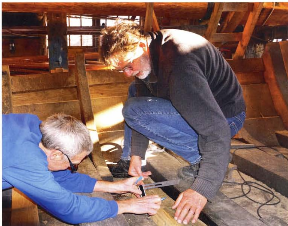
Vrijwilligers Sieb Keizer (rechts) en Henk Meijer (links) brengen met een zweihaak de hoek van een knie over op de ligger die er passend tegenaan moet komen.
