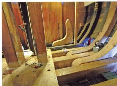
boven: Bij Henk van der Meulen in Sneek wordt een nieuw zeilwerk en mastspoor gemaakt. Dat is geen eenvoudige klus in een bestaand schip. Er is een huidgang verwijderd om het gezaagde hout naar binnen te kunnen schuiven
