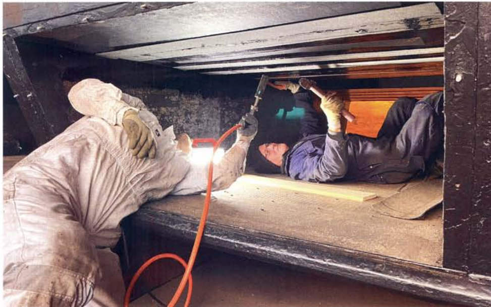
boven: Het schip wordt aangepakt, de rotte plekken worden uit de zwaarden gehaald
