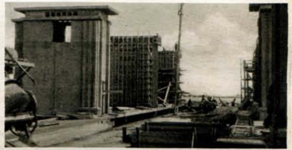
53 Heftorens op de uitwateringssluizen
