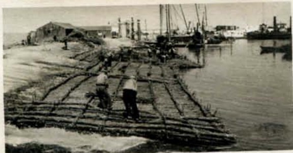
Vlechten van het bovenroosterwerk
