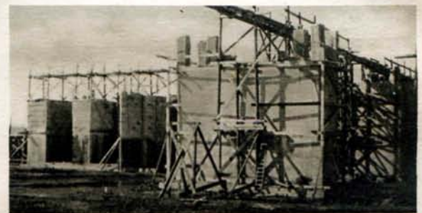
55 Pijlers van de spoorbrug te Kornwerderzand in aanbouw
