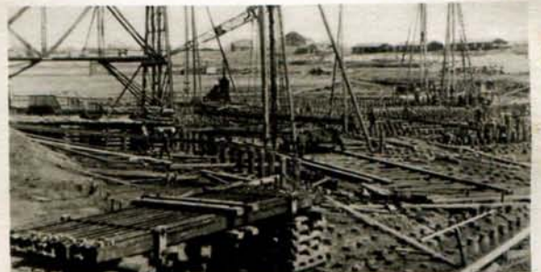
Heistellingen in den bouwput te Kornwerderzand
