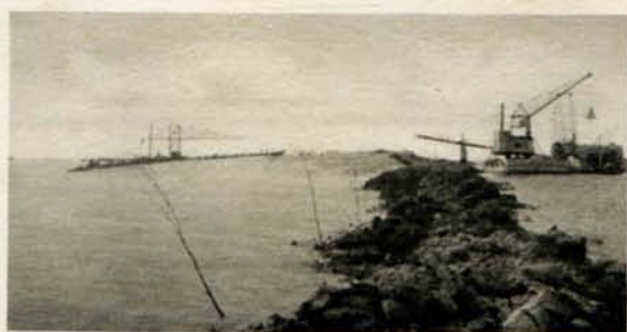
20 De afsluitdijk in aanleg gezien vanaf de zeezijde
