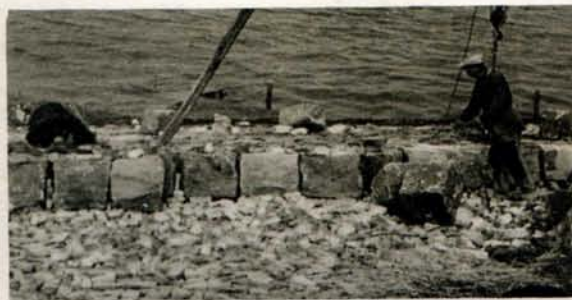
Het controleren der glooiing door de zeters
