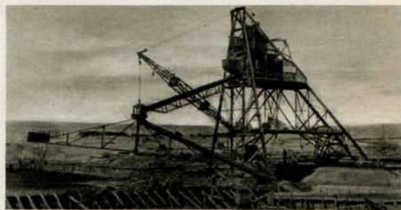
45 Betonmolen met stortgoot
