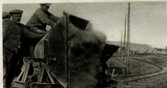
47 Storten van cement en tras in den bak van den betonmolen
