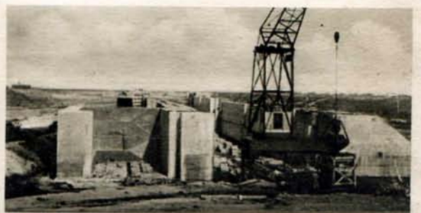
56 Scheepvaartsluis te Den Oever in aanbouw
