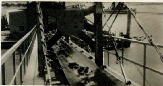
Keileem op den transportband
