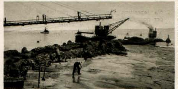
21 De afsluitdijk in aanleg gezien naar de zeezijde
