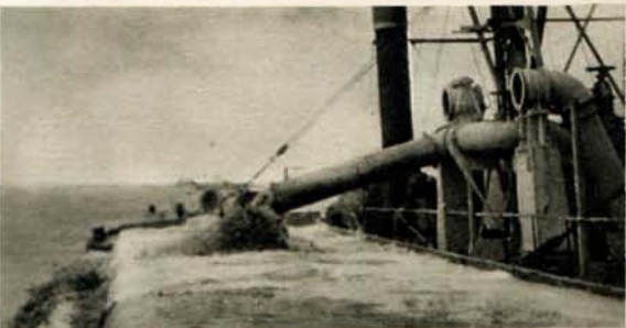
12 Het laden van een elevatorbak door een grondzuiger
