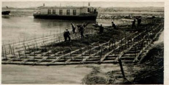
24 Op het onderroosterwerk worden bossen rijshout gelegd
