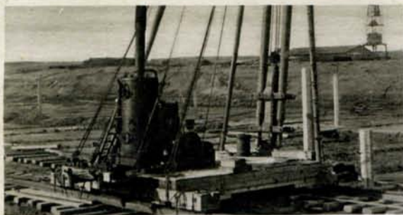
41 Heimachine met blok van 4000 K.G.
