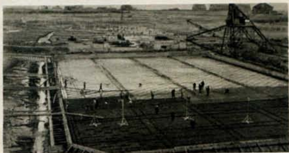
44 Betonvloer voor de uitwateringssluizen in aanbouw
