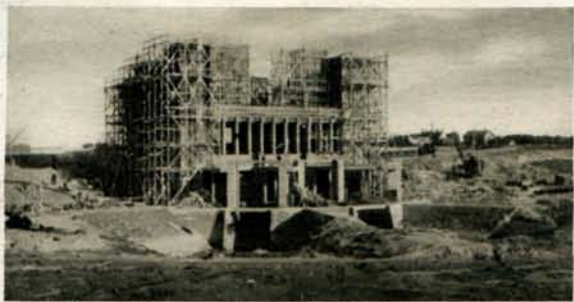
57 Electrisch gemaal bij Medemblik in aanbouw
