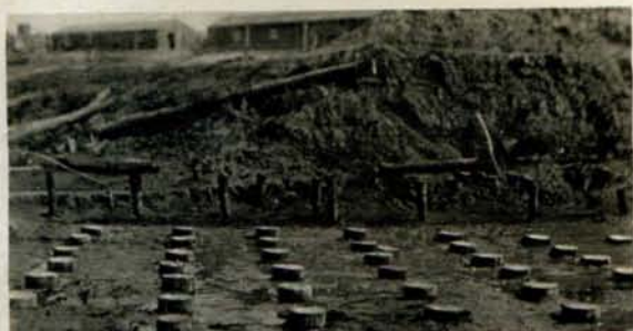
43 Op gelijke hoogte afgezaagde heipalen
