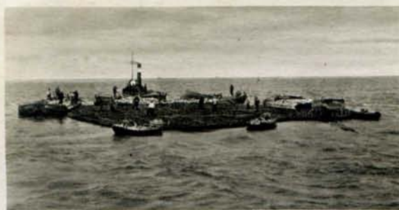
Vervoer van een voltooid zinkstuk
