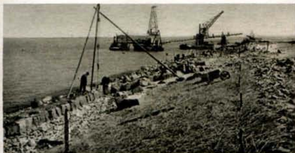
Het steenzetten met behulp van een bok
