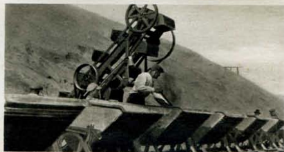
46 Vullen der kipkarren met zand en grind
