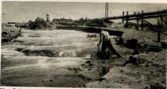
19 Zuigerstort met gedeeltelijk voltooid zandlichaam
