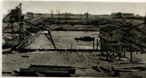
51 De plaat volgestort
