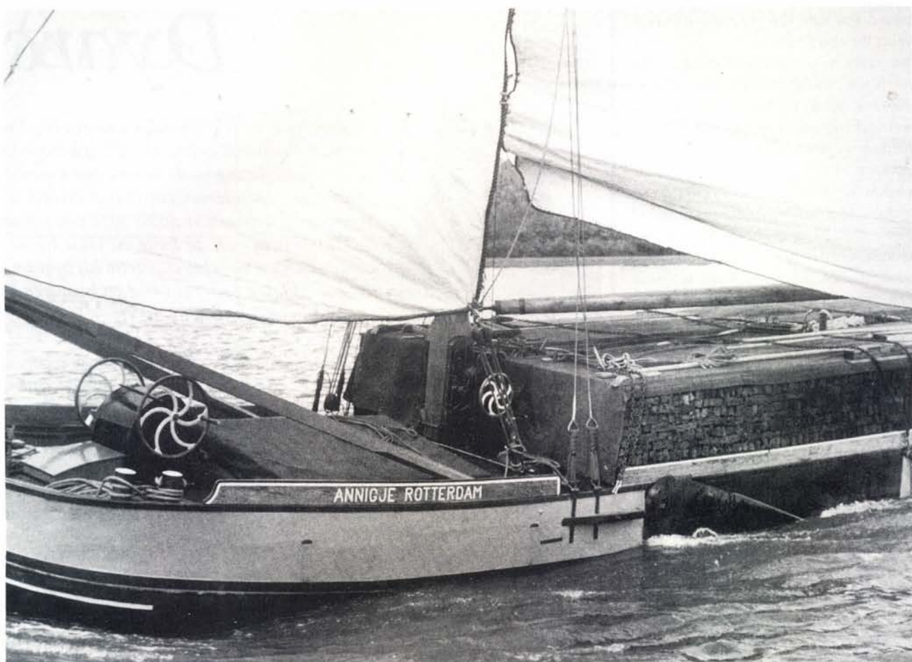
De Annigje, geheel geladen in 1987. Duidelijk zichtbaar is de opbouw van de deklast. Eerst een laag kopturven, daarna scheerturven, kopturven, enz.
