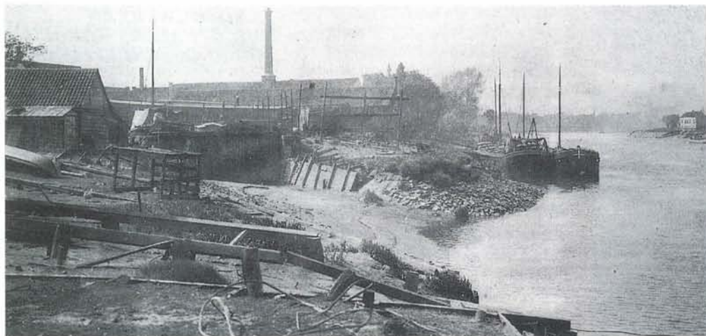
Het getijdedroogdok van de scheepswerf Van Praet omstreeks 1900. De vaargeul is bij laag water drooggevalen. Op de voorgrond is de langshelling van dezelfde scheepswerf te zien.
