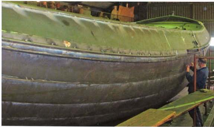
De bouw van het casco
