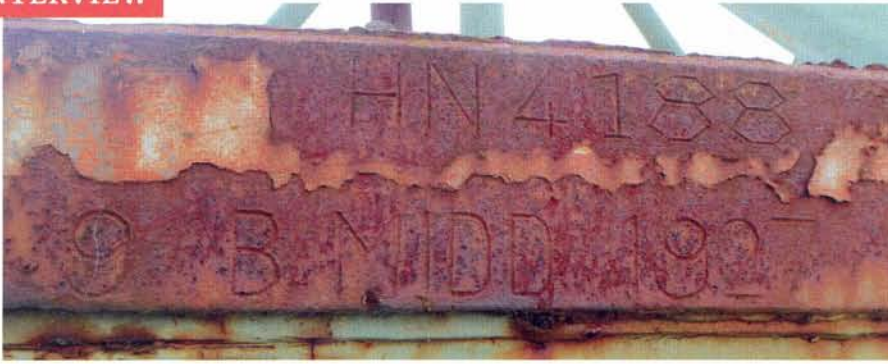
Het brandmerk 9 B Midd 1927 (kadasterkantoor Middelburg) is opnieuw ingehakt in 1994 onder het meetnummer HN4188 'op het achterschip aan BB-zijde in achterwand dekhuis'. Het schip Zandkreek heeft een gevarieerd leven gehad als veerboot, dekschuit, zelfvarende kraan en ponton, en is veelvuldig verbouwd Foto Jan Meppelink
