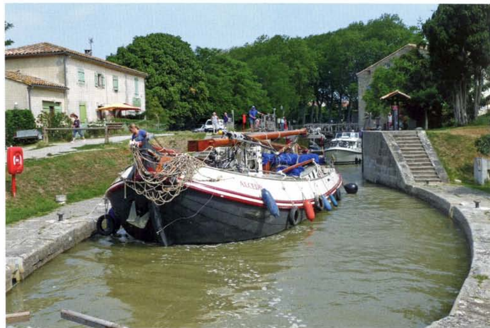
Aanleggen in een volle sluis kolk is een stuk gemakkelijker.
