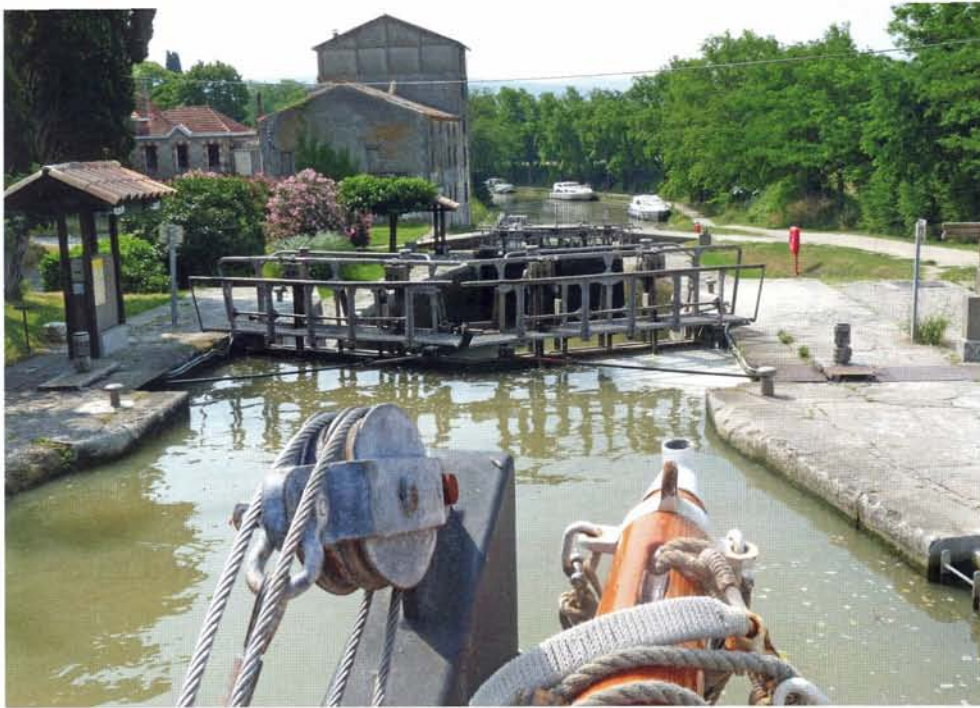
Afdalen in de drietrapsluis Trébes.
