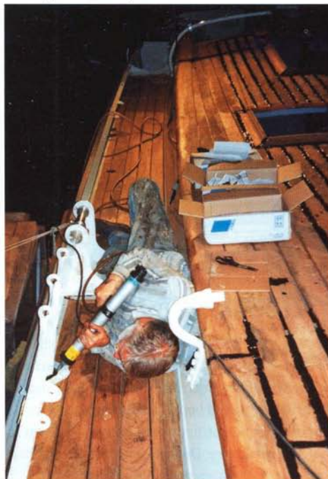
Het rubberen van de naden van het dek.
