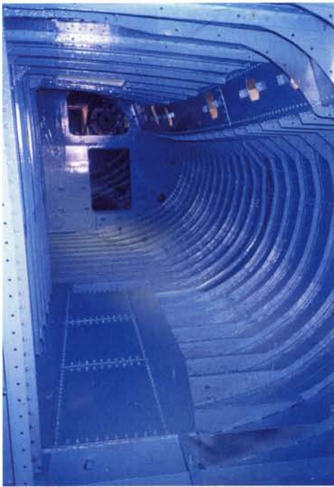
Binnenkant in de grondverf met één drinkwater-tank met drie grote mangatdeksels en de opening naar de machinekamer.
