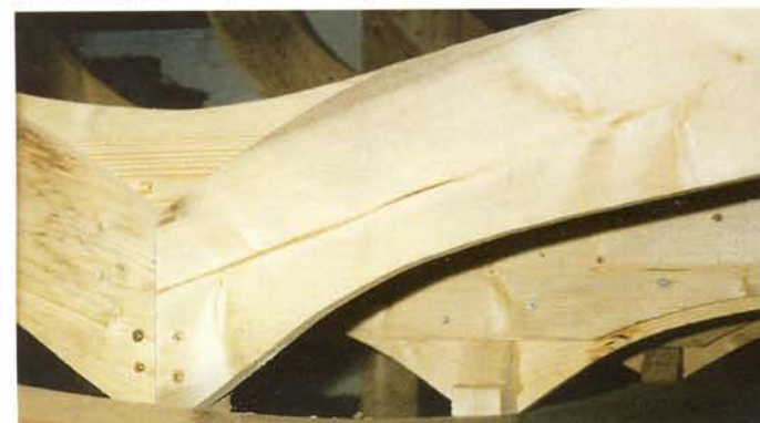
Detail van de gepiekte spanten.
