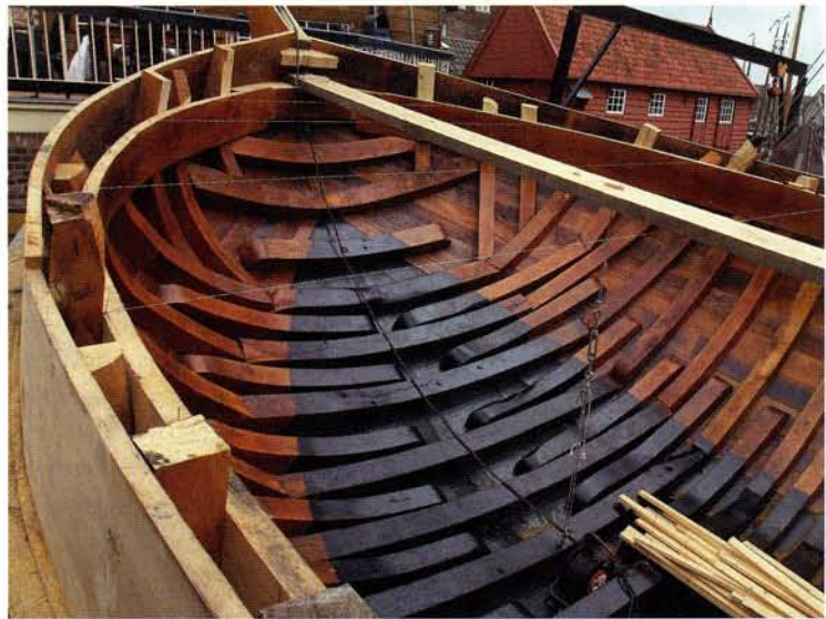
Alle spanten, leggers, zitters en oplangers, alsmede de huid, zijn vernieuwd
