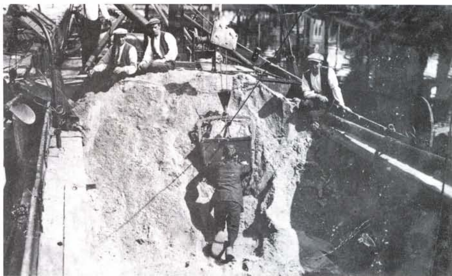
Het werken achter en met de losbak was niet ongevaarlijk. Foto: collectie Thijs van Rossum.
