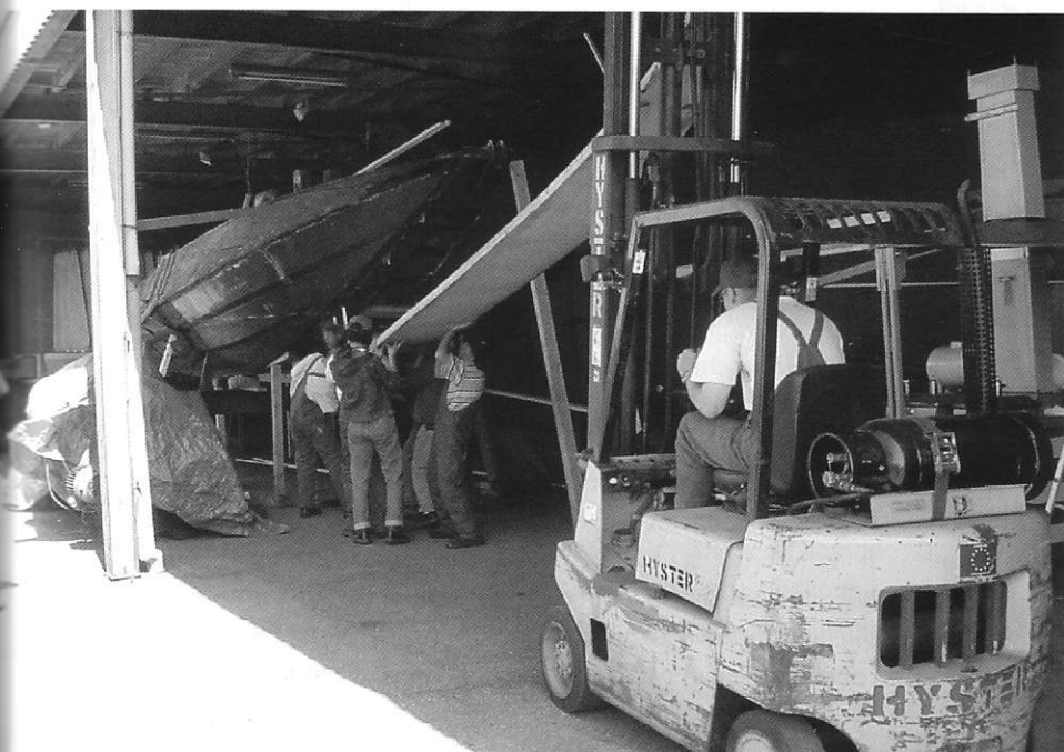
Aanbrengen eerste vlakdeel.
