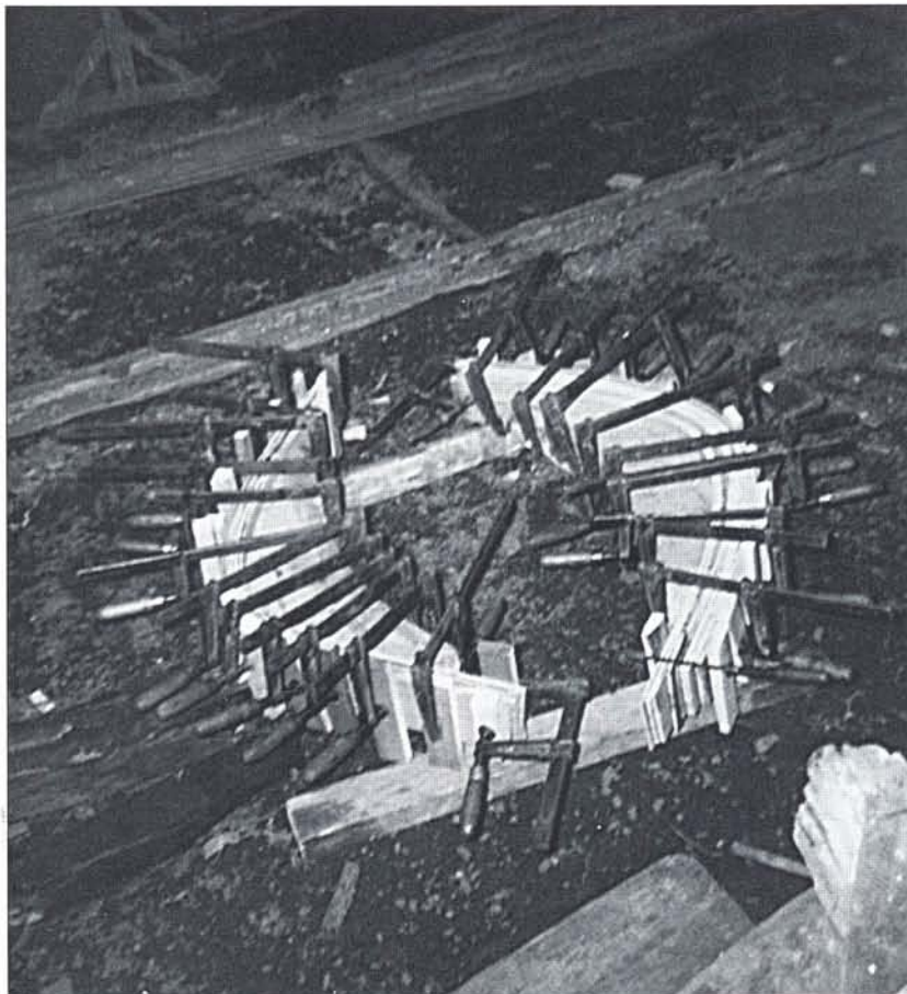
Gelamineerde spanten.
