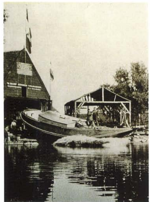
Op de werf 'k Blijf Steeds Volharden' van Melis van Duivendijk te Willemstad, de tewaterlating van de hoogaars Havik voor de visserijinspectie (1902).
