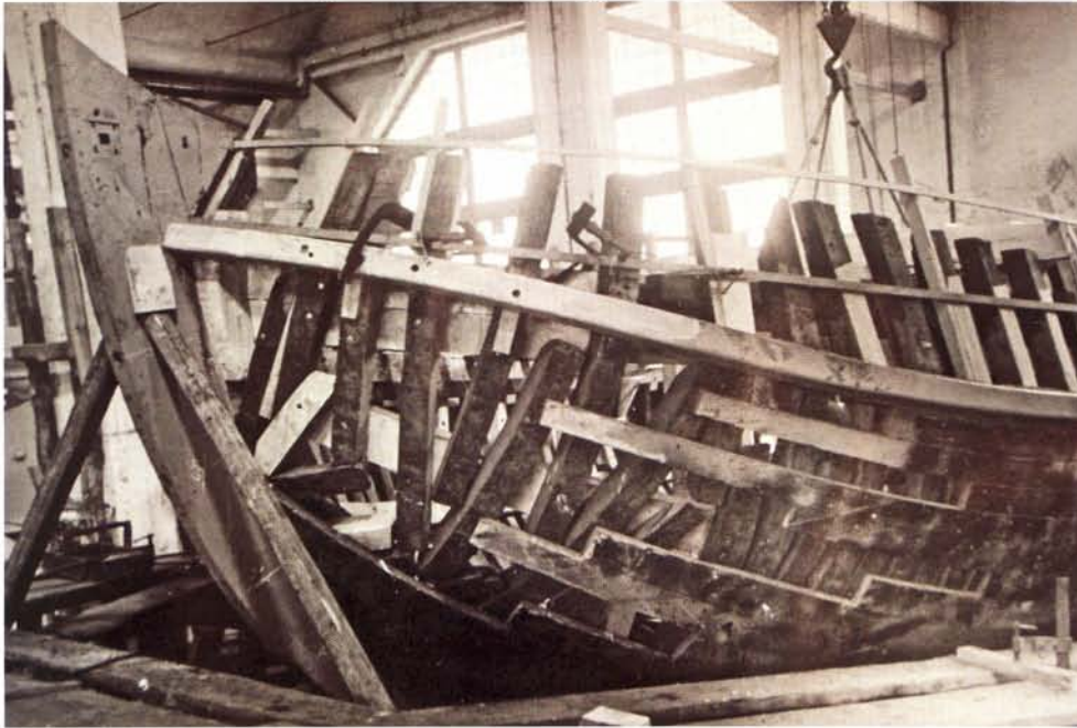
De restauratie bij Baglietto.
