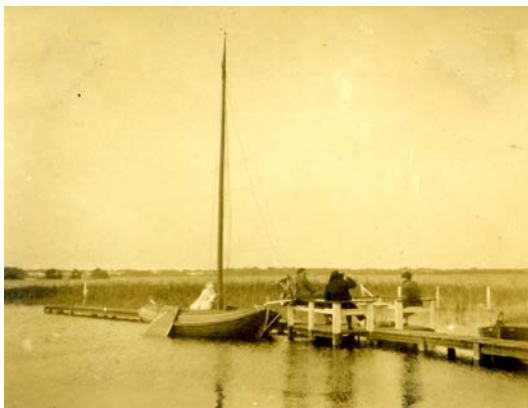
fotograaf en datum onbekend Poseidon aan een steiger bij het Paterswoldsemeer. De fok die gevoerd wordt is horizontaal gesneden. Dit wijkt af van het gebruikelijke verticale.
