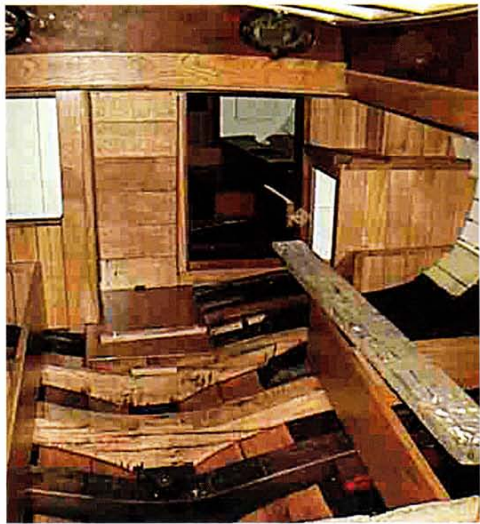
Tijdens de restauratie bij Piersma werd het mastspeer en een behoorlijk aantal leggers, de mastkoker, een stuk van de mastbalk, de dekbalk, de piek, enkele gangen, een stuk van de steven, stukken van het boeisel en 'nog wat klein werk' vernieuwd.
