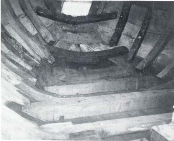
Binnenzijde romp BB gereed.
