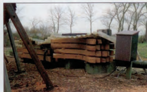
Een stapel nieuwe zitters ligt klaar om aangebracht te worden.
