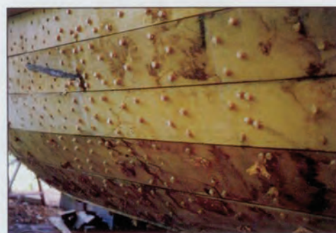
Alle bevestigingsbouten worden afgedopt.
