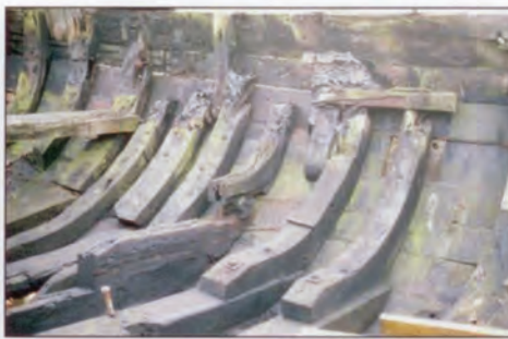
Binnenkant romp met spoorbiels als liggers.
